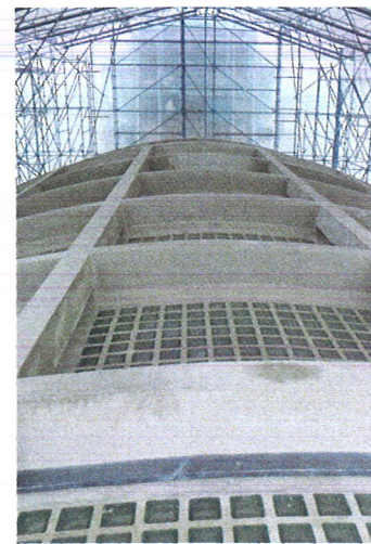
La réfection du hall comprenait l'application en toiture d'une étanchéité liquide à base de PMMA.
